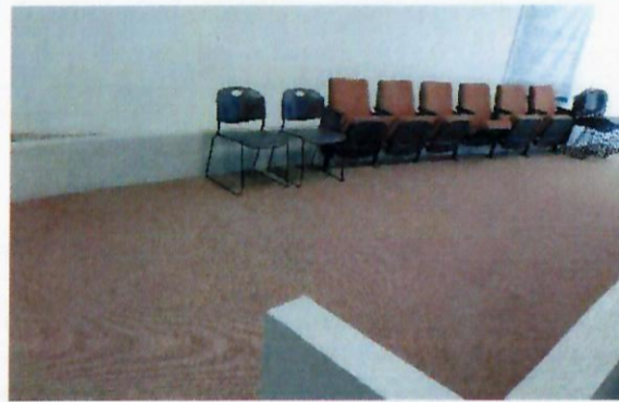
F7: Se colocaran Butacas para auditorio distribuidas en el lado izquierdo y derecho del mismo.
