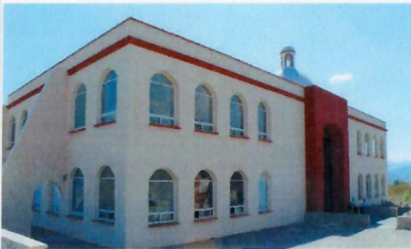
F1: Fachada principal
