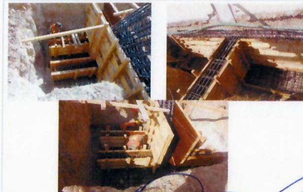
F23: Habilitado de cimbra de zapata aislada y contratraves.
