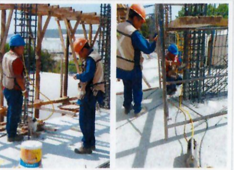
F16: Pruebas de laboratorio para bujos en columnas.
