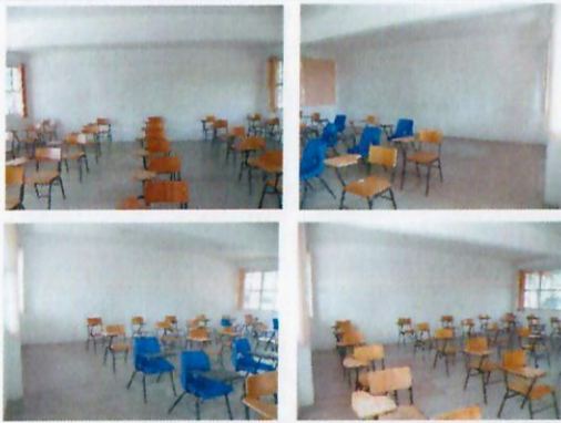
F18: Colocación de Butacas en diferentes Aulas.
