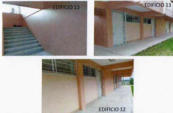
F10: Se colocarán extintores en Edificio 12 y 13.
