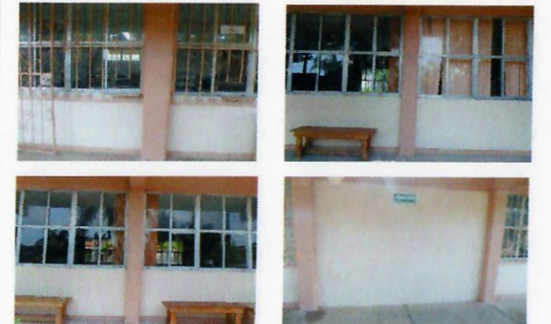
F11: Colocación de extintores afuera de pasillo edificio 1, pasillo de edificio 3 y pasillo de edificio 2.
