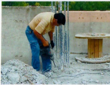
F7: Demolición de concreto que recubría al acero de columnas
