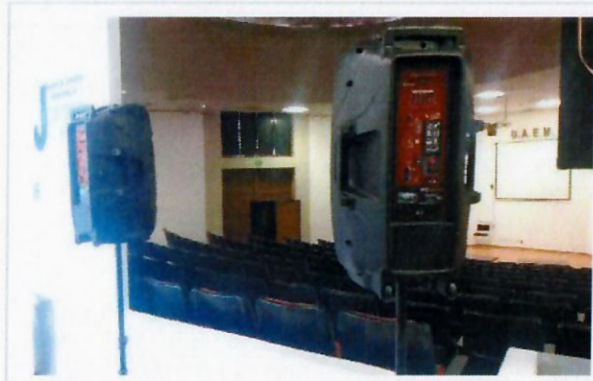
F23: Baffles Instalados
