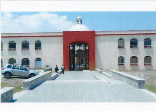
F1: Fachada principal
