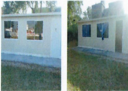
F18: Se colocarán 2 aires acondicionados en el salón 14 y en el salón 15
