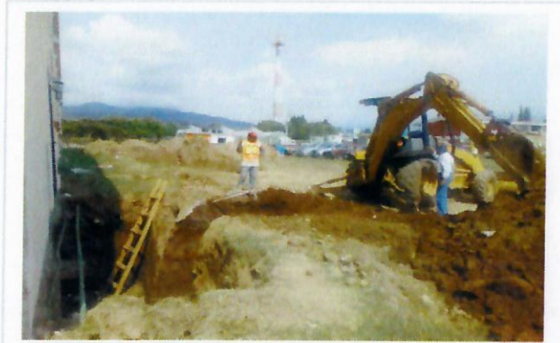
F11: Excavación de terreno
