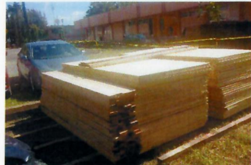
F11: Suministro de madera para cimbra
