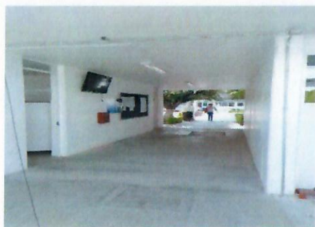
F12: Se colocaran 2 extintores en el pasillo del edificio 2
