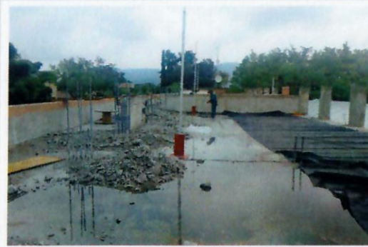
F8: Demolición de concreto pobre que recubría al acero de columnas
