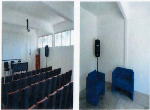
F22: Instalación de Baffles en Sala Audiovisual y espacio de Cabina de radio y television.
