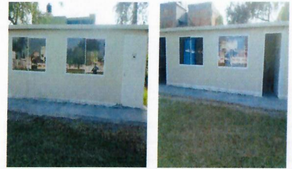
F17: Se colocarán 2 aires acondicionados en el salón 12 y en el salón 13
