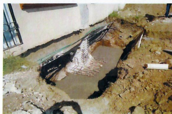
F13: Plantilla de concreto.
