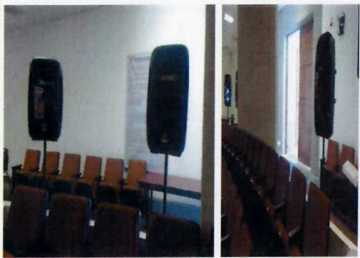
F22: Baffles Instalados
