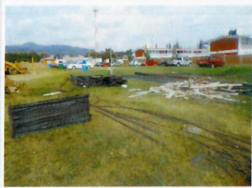
F15: Suministro de materiales.
