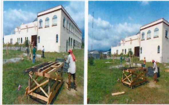
F7: Habilitado de acero para contrafuertes.
