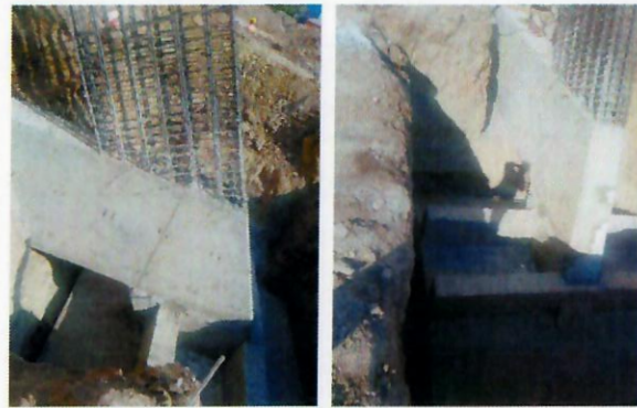
F25: Descimbrado de zapata, contratrabe y trabe de liga.
