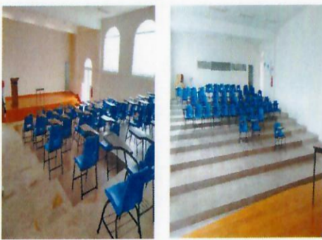
F12 : Se colocará 3 mini split de 2 t.r. en el área 6. Auditorio
