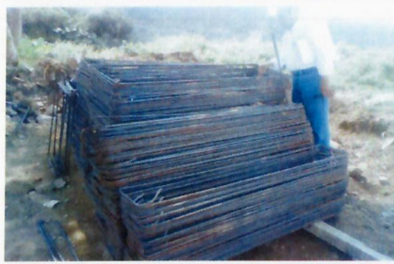
F16: Habilitado de acero.
