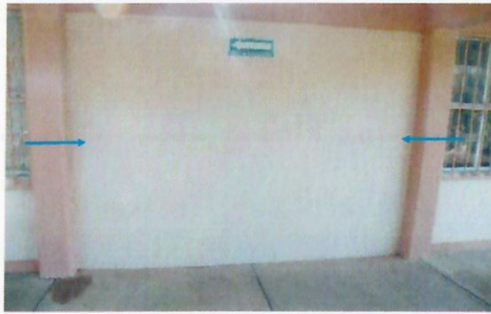
F7: Se colocaran Lockers en Pasillo edificio 3
