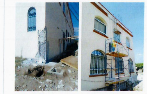
F17: Demolición de elementos estructurales para empotramiento de contrafuerte.
