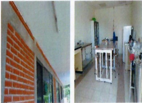
F9: Se colocarán extintores en los laboratorios de Biología y cocina bioterio.
