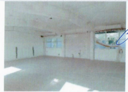
F6: Interior de aula
