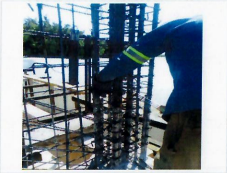
F13: Elaboración de bujos en varillas de 1" y 1 1/2" de columnas.
