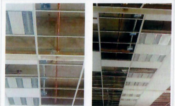
F18: Colocación de tubería de cobre.
