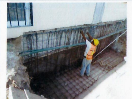
F18: Habilitado de acero de contratrabe nueva con contratrabe existente.
