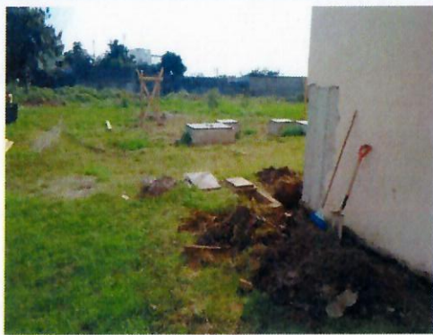
F9: Excavación para contrafuertes.
