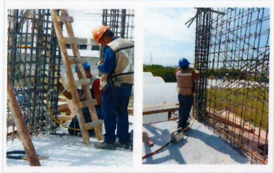
F15: Pruebas de laboratorio para bujos en columnas.
