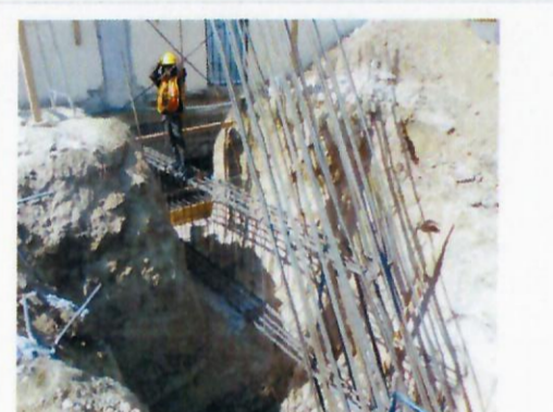
F21: Habilitado de acero para trabe de liga y contrafuerte.
