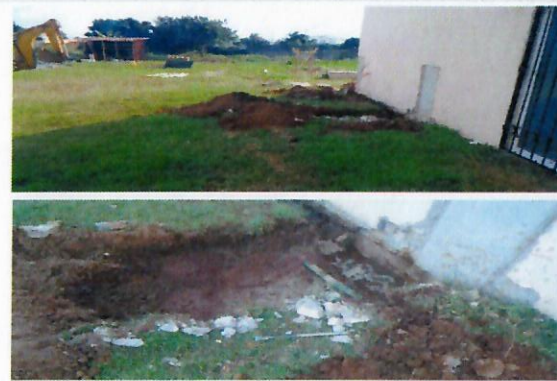
F10: Excavación para contrafuertes.
