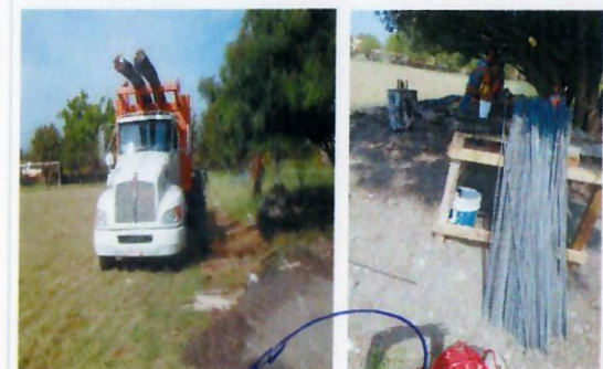
F12: Suministro y habilitado de acero
