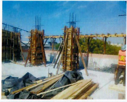
F22: Habilitado de cimbra para muros y columnas.
