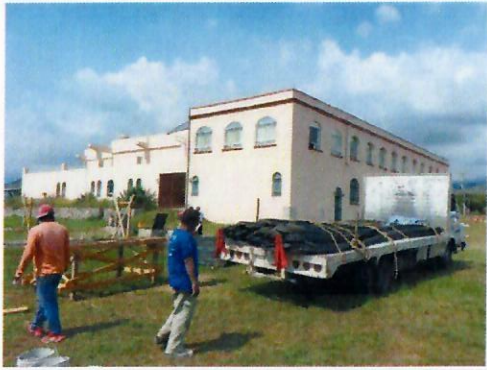
F6: Se inician trabajos en la estructura del edificio para la construcción de los contrafuertes.
