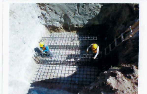
F20: Habilitado de acero de zapata aislada y contratraves.
