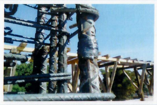
F14: Elaboración de bujos en varillas de 1" y 1 1/2" de columnas.
