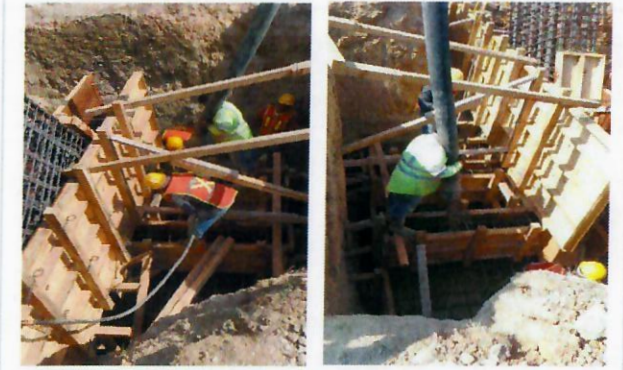
F26: Colado con concreto f_c=250 kg/cm 2 de zapata, contratrabe y trabe de liga.
