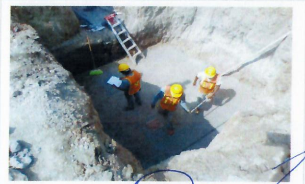
F14: Trazo de ejes sobre plantilla de concreto.
