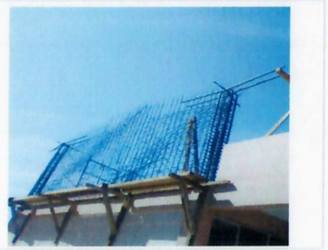
F19: Habilitado de acero para muros y columnas.
