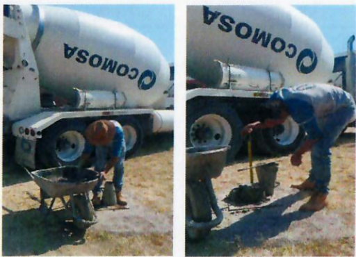
F24: Pruebas de revenimiento al concreto.
