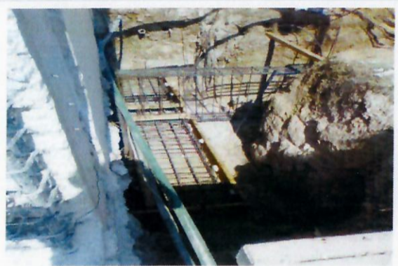
F19: Habilitado de acero de zapara y trabe de liga.
