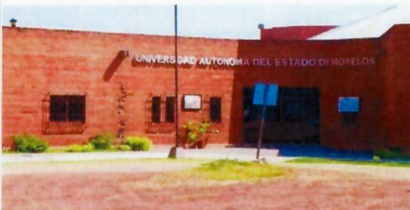
F1: Fachada principal
