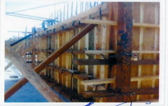
F21: Habilitado de cimbras para muros y columnas.
