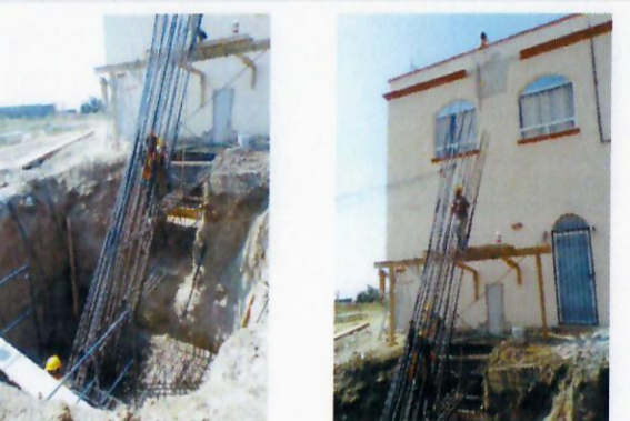
F22: Habilitado de acero para contrafuerte.
