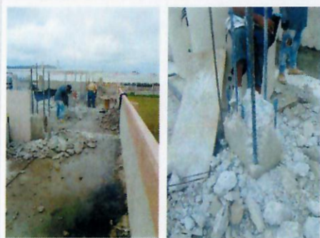
F10: Demolición de concreto pobre que recubría al acero de columnas
